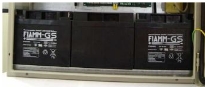
Рис. 31: Правильная установка аккумуляторов
