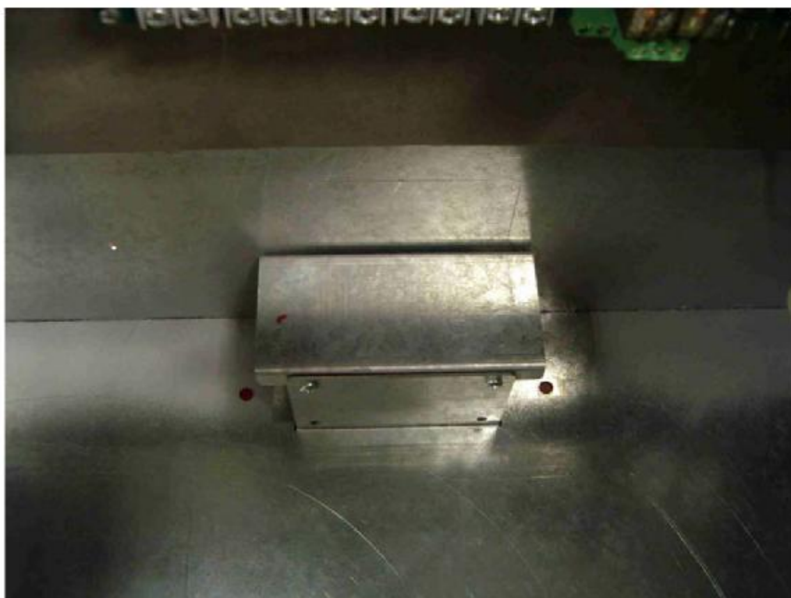
Рис. 12: Ввод кабеля через стену — защитная крышка
