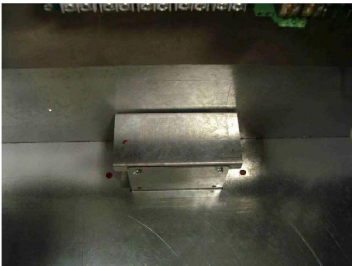
Рис. 12: Ввод кабеля через стену — защитная крышка
